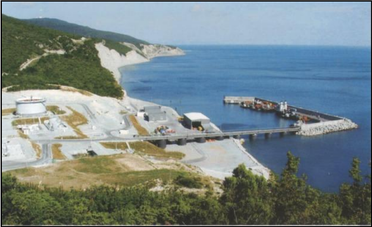
Рис. 1. Островной порт для вспомогательного флота Каспийского трубопроводного консорциума в пос. Южная Озеревка к западу от Новороссийска
